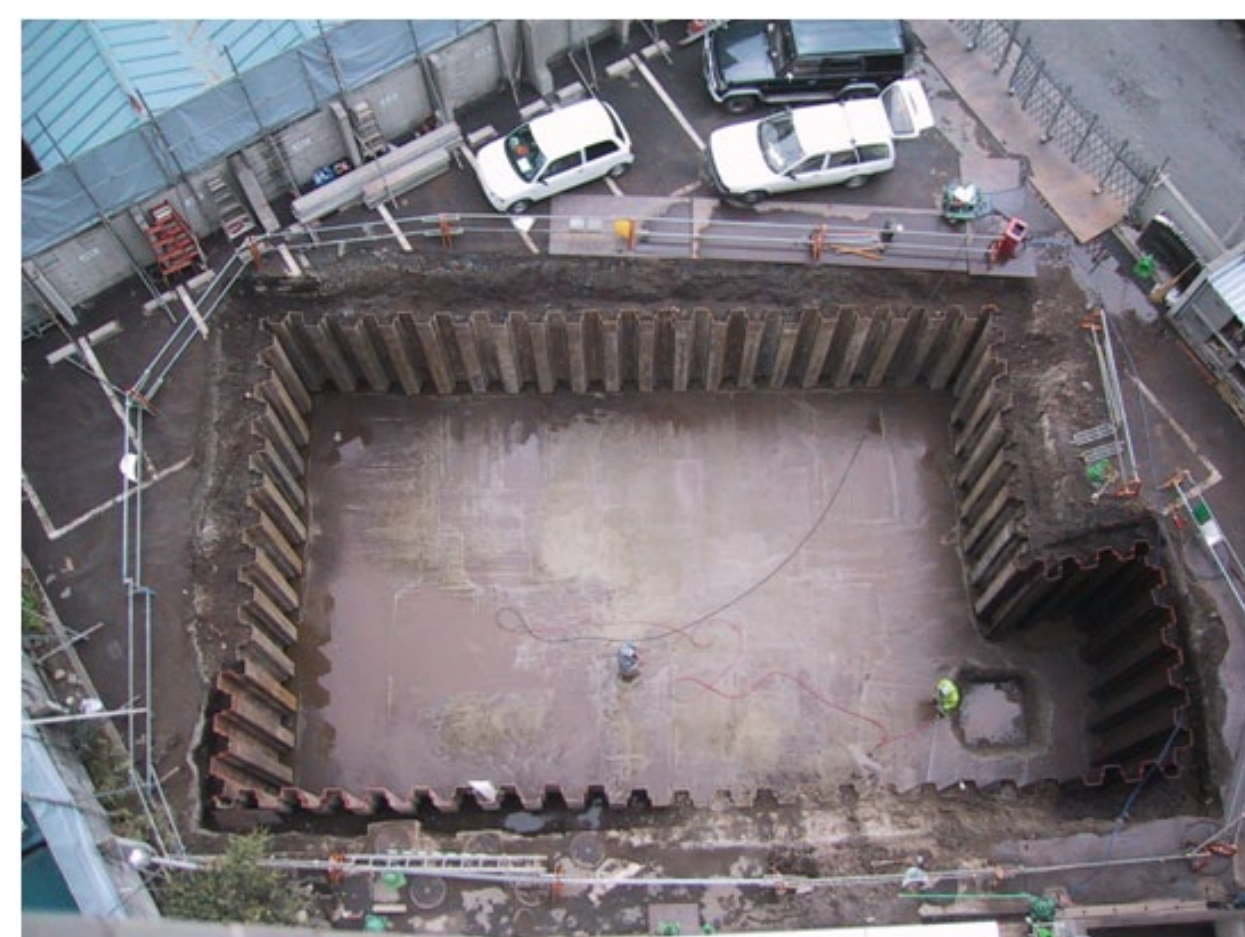
水蓄熱槽を建物南側に駐車場地下に新規築造(370 m 3 )
