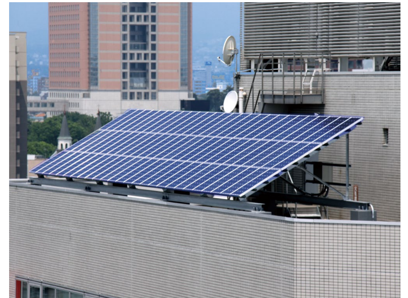
屋上に太陽光発電パネルを設置
