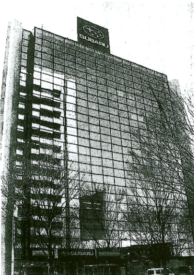
省エネへの取り組みが評価された富士オート本社ビル
