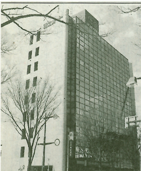
省エネ型として04年に稼働した本社ビル
