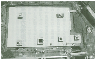
蓄熱槽全景（上部スラブシート防水完了段階）
