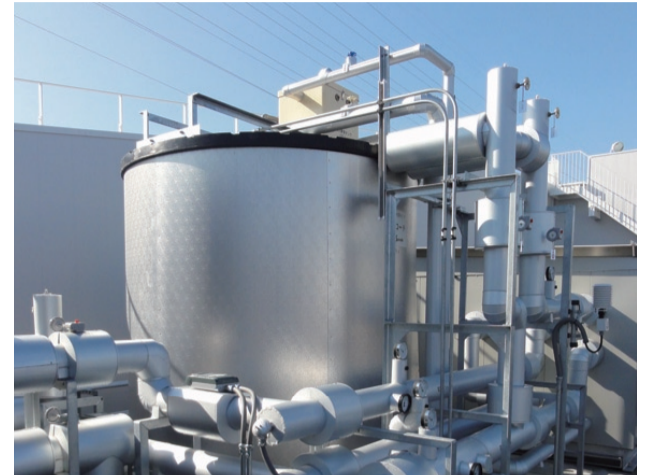
熱源システムには氷蓄熱システムと高効率チラーを採用。ランニングコストの削減を図っています。
